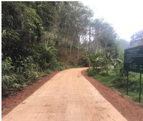
ภาพถ่ายโครงการก่อสร้างถนนคอนกรีตเสริมเหล็กสายวังไต่ะหมุ่ม หมู่ที่ ๖ บ้านหินจอก ข้อบัญญัติปีพ.ศ. ๒๕๖๖
