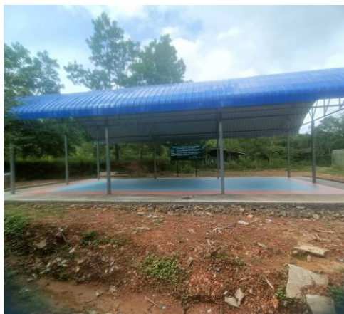
ภาพถ่ายโครงการก่อสร้างอาคารอเนกประสงค์ประกอบศพด.บ้านท่าเขา หมู่ที่ ๕ บ้านท่าเขา ข้อบัญญัติปีพ.ศ. ๒๕๖๖
