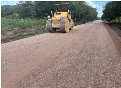
ภาพถ่ายโครงการปรับปรุงผิวจราจรถนนลาดยางแบบแอสฟัลท์ติกคอนกรีต สายเขาไต่ะร่วง - ทุ่งมะขามป้อม หมู่ที่ ๒ -หมู่ที่ ๔
