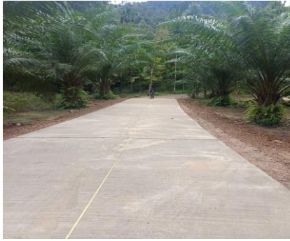
ภาพถ่ายโครงการก่อสร้างถนน คสล.สายหลังโรงเรียนบ้านเขาดิง หมู่ที่ ๕ บ้านท่าเขา
