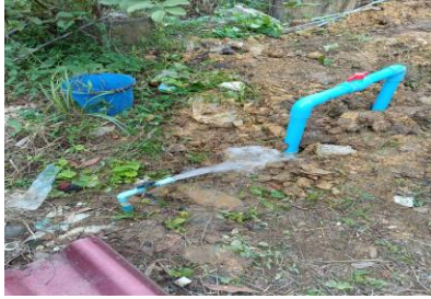
ภาพถ่ายโครงการขยายเขตระบบประปาหมู่ที่ ๒ บ้านทุ่งปาหนันและหมู่ที่ ๔ บ้านคลองแร้
