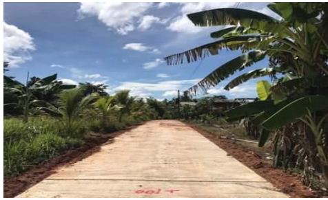
ภาพถ่ายโครงการต่อเติมถนนคอนกรีตเสริมเหล็กสายไร่ใหญ่ - ทุ่งหน้าถ้ำ หมู่ที่ ๑ บ้านลิพัง
