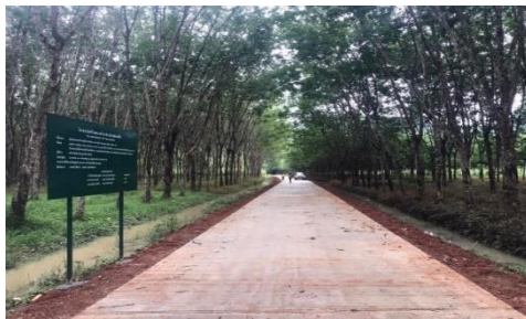
ภาพถ่ายโครงการก่อสร้างถนนคอนกรีตเสริมเหล็กสายเขาน้ำเต้า หมู่ที่ ๕ บ้านท่าเขา
