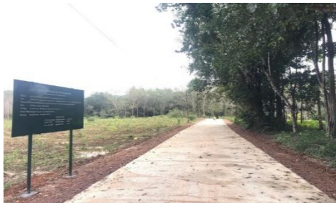
ภาพถ่ายโครงการก่อสร้างถนนคอนกรีตเสริมเหล็กสายวังข้าง หมู่ที่ ๗ บ้านทางสาย
