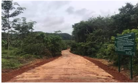
ภาพถ่ายโครงการเสริมผิวจราจรยางพาราแอสฟัลท์ติกคอนกรีตสายต้นกอ - สี่แยกใน หมู่ที่ ๑ บ้านลิพัง
