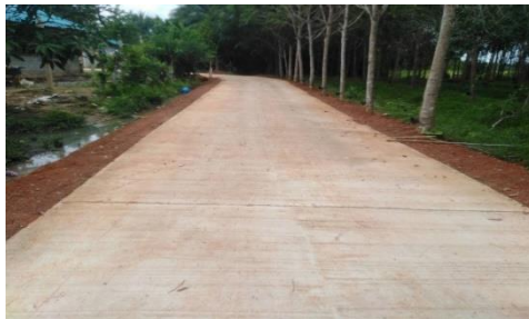
ภาพถ่ายโครงการก่อสร้างถนนคอนกรีตเสริมเหล็กสายทอนร็อก หมู่ที่ ๗ บ้านทางสาย
