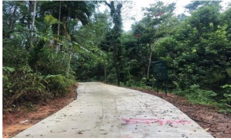
ภาพถ่ายโครงการก่อสร้างถนนคอนกรีตเสริมเหล็กสายหลังอนามัย หมู่ที่ ๗ บ้านทางสาย
