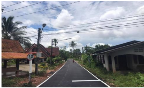
ภาพถ่ายโครงการก่อสร้างถนนคอนกรีตเสริมเหล็กสายบ้านนายบุญ หมู่ที่ ๒ บ้านทุ่งปาหนัน
