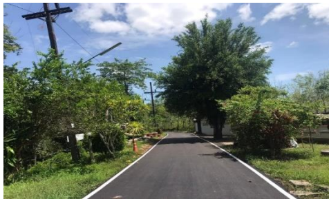
ภาพถ่ายโครงการก่อสร้างถนนคอนกรีตเสริมเหล็กสายควนดินแดง-นาทม หมู่ที่ ๔ บ้านคลองแร
